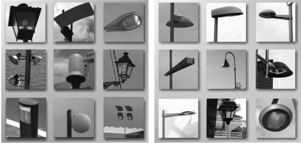
Figura 14. Ejemplos de luminarias fuertemente contaminantes (izquierda) y luminarias sin emisión hacia arriba (derecha) (IAC / OTPC).
